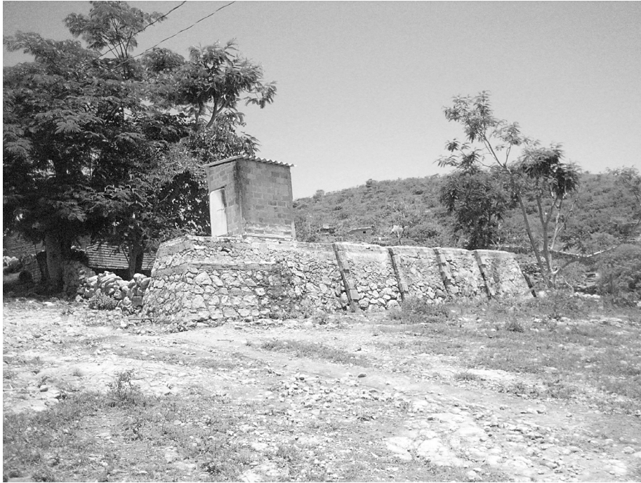
Imagen 6. Tanque de almacenamiento de la misión con capacidad de 30 000 litros
